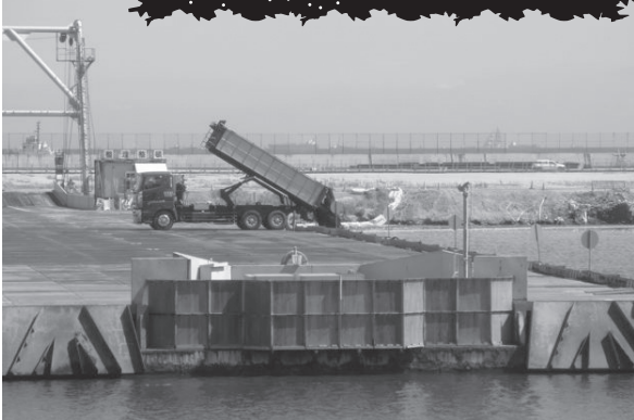
▲ダンパーが次々と荷台から投棄。投棄された容量分の水は処理して外海に排出する。(南本牧最終処分場)
